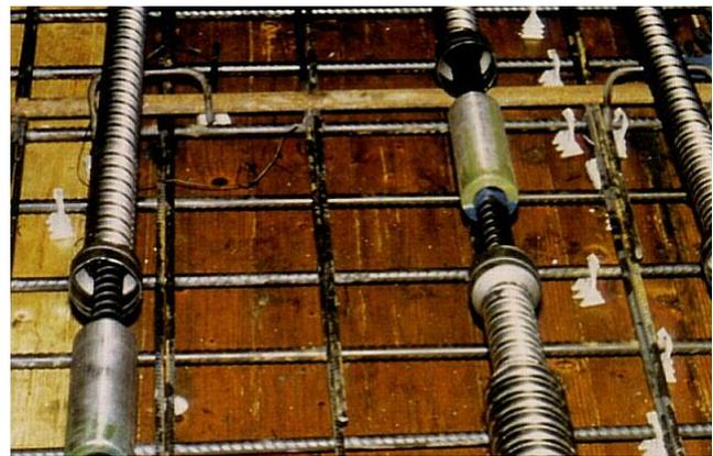
Figura 5.19. Anclaje con tuerca esférica y empalme de barras mediante manguito
