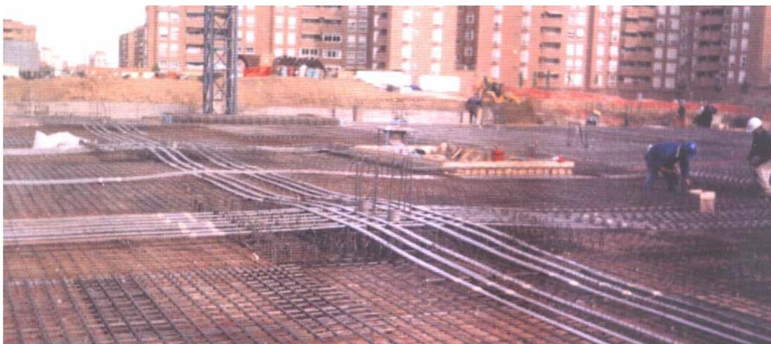
Figura 14. Aspecto de la ferralla y de las vainas antes del hormigonado de la losa del primer nivel.
