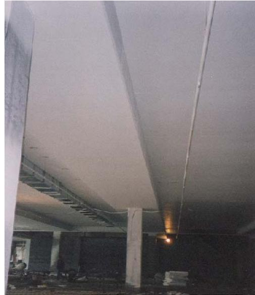
Viga de Canto unidireccional + Losa: igual que el anterior, pero puede cubrir luces mayores y recibir grandes cargas concentradas (vigas cargadero). El trazado es igual al anterior.
