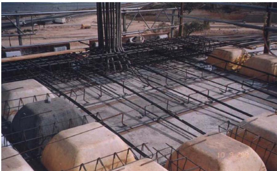
Figura 3. Vista del forjado reticular con cables monocordón.
