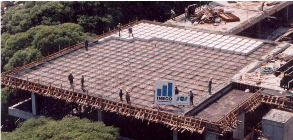
Vigas planas en dos direcciones + Losa: se recomienda cuando las luces en ambas direcciones superan los 13-15m y las cargas son medias a pesadas, pero su utilización no es muy común por el alto costo del encofrado, la mano de obra y la complicación para el tendido de instalaciones. La disposición en planta de los tendones puede ser concentrada en ambas direcciones o mixta en ambas direcciones.
