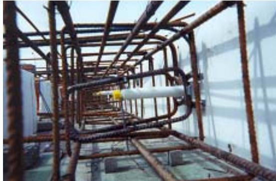
Foto 3: Armadura de refuerzo y Zuncho de Borde
