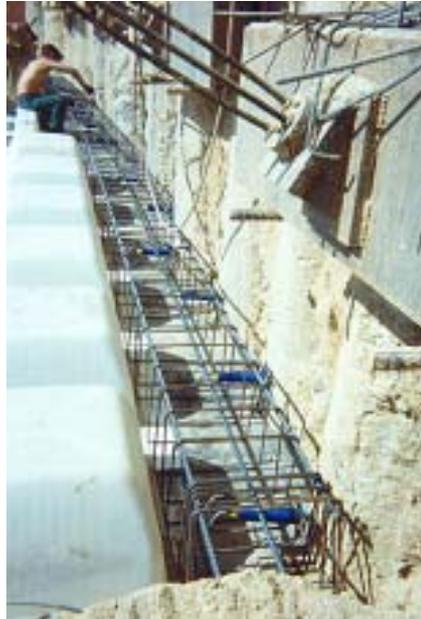
Foto 4: Colocación de Pasadores en pantalla de pilotes
