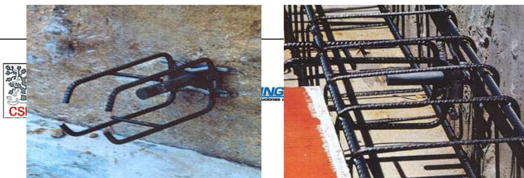
Figura 12: Colocación del Zuncho de Refuerzo y Zuncho de Borde
