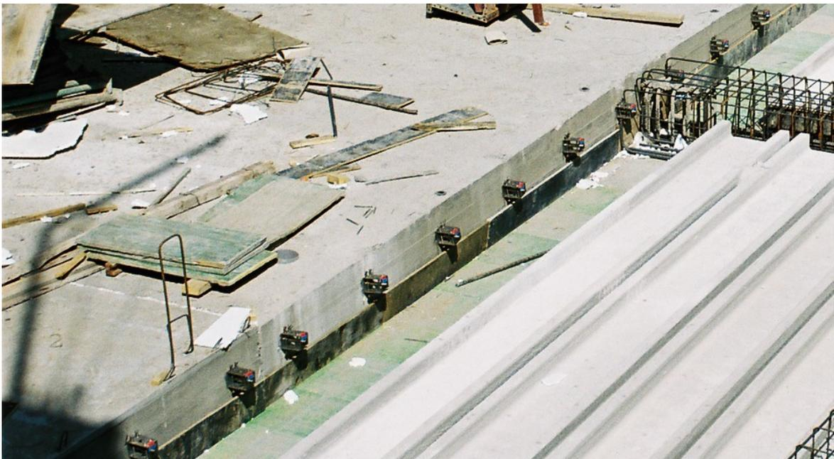
Foto-3: Reparto de conectores con carga uniforme.
