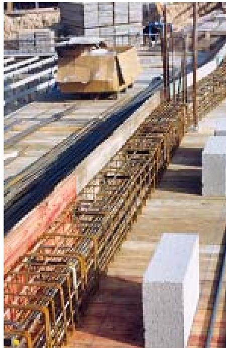
Foto 2: Disposición de Pasadores en Junta de Dilatación
