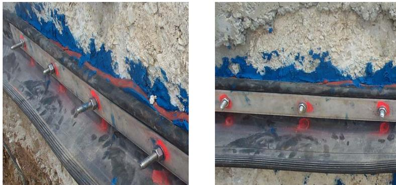
Figura 9: Colocación de junta para estanqueidad.
